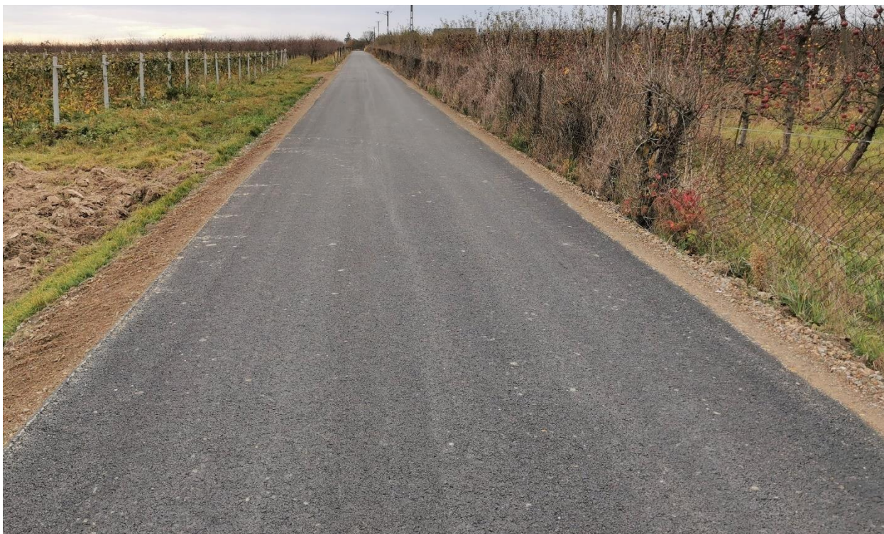
Zdjęcie 2 Modernizacja (przebudowa) drogi dojazdowej do gruntów rolnych w miejscowości Świdno
