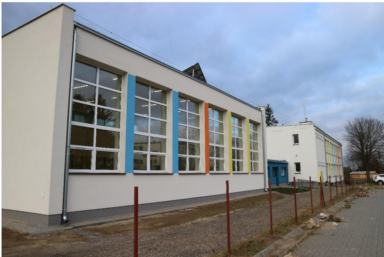
Zdjęcie 6 Termomodernizacja budynku Szkoły Podstawowej w Ratoszynie Drugim
