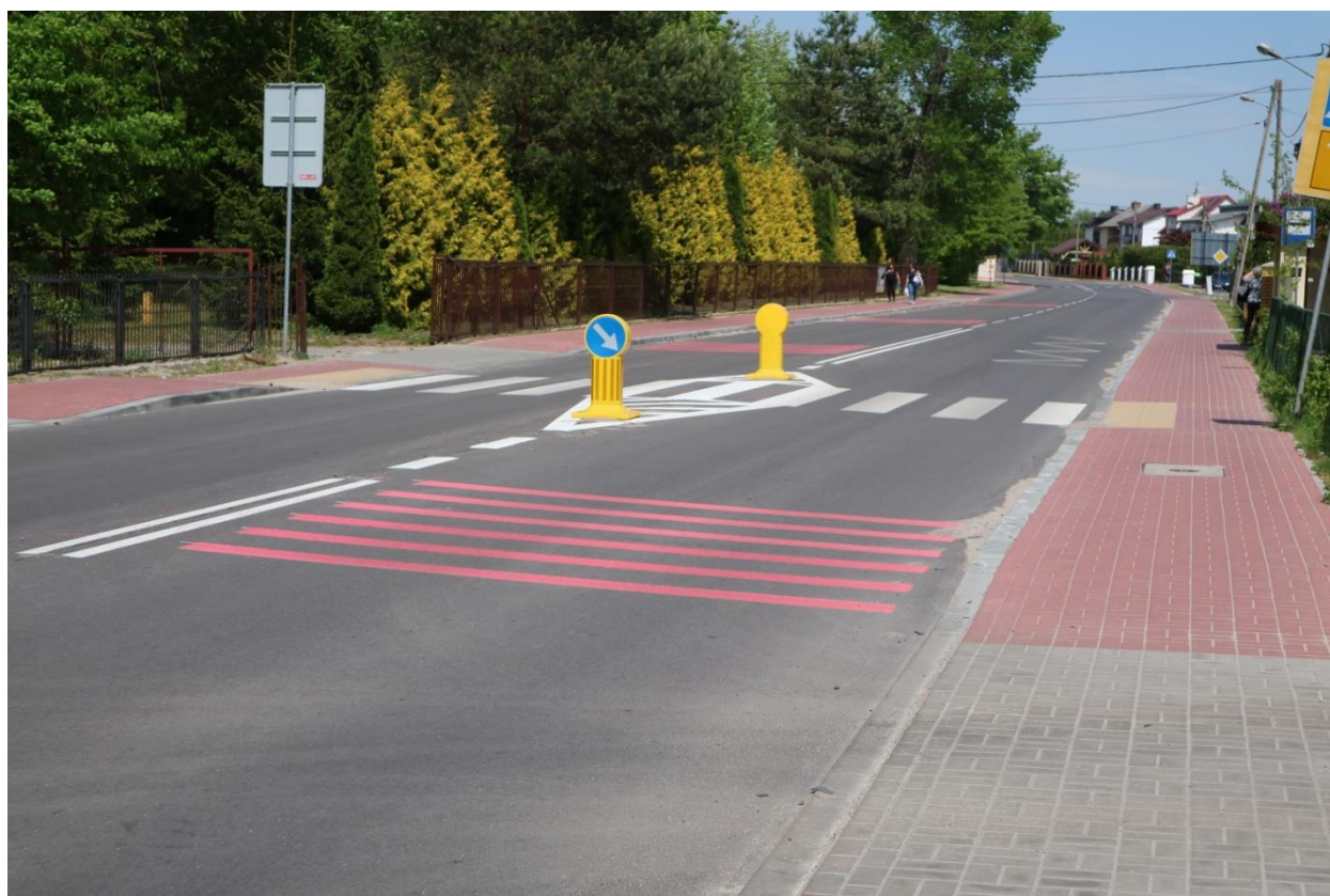
Zdjęcie 1 Przebudowa byłej drogi wojewódzkiej (ul. Partyzantów) w miejscowości Chodel
