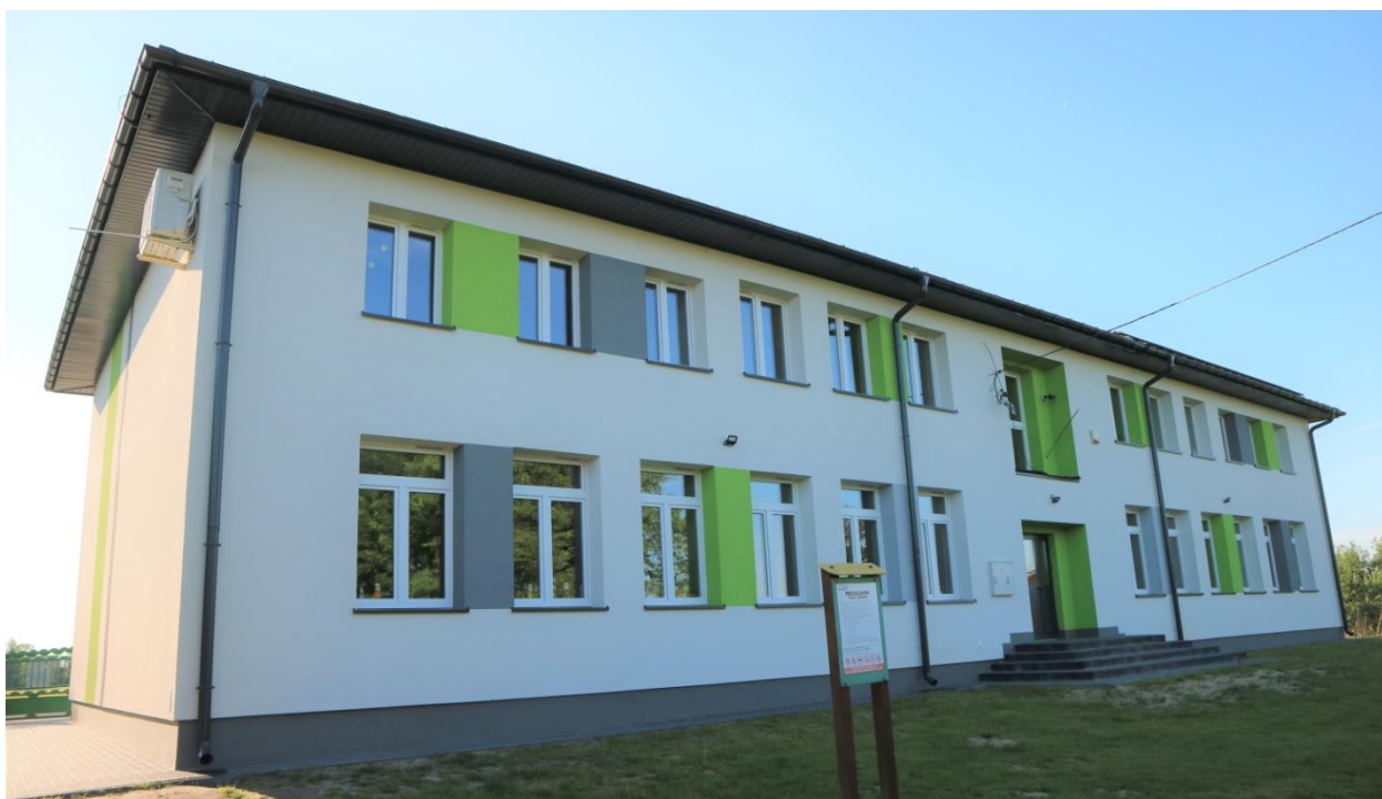
Zdjęcie 5 Kompleksowa modernizacja energetyczna budynku Szkoły Podstawowej w Granicach
