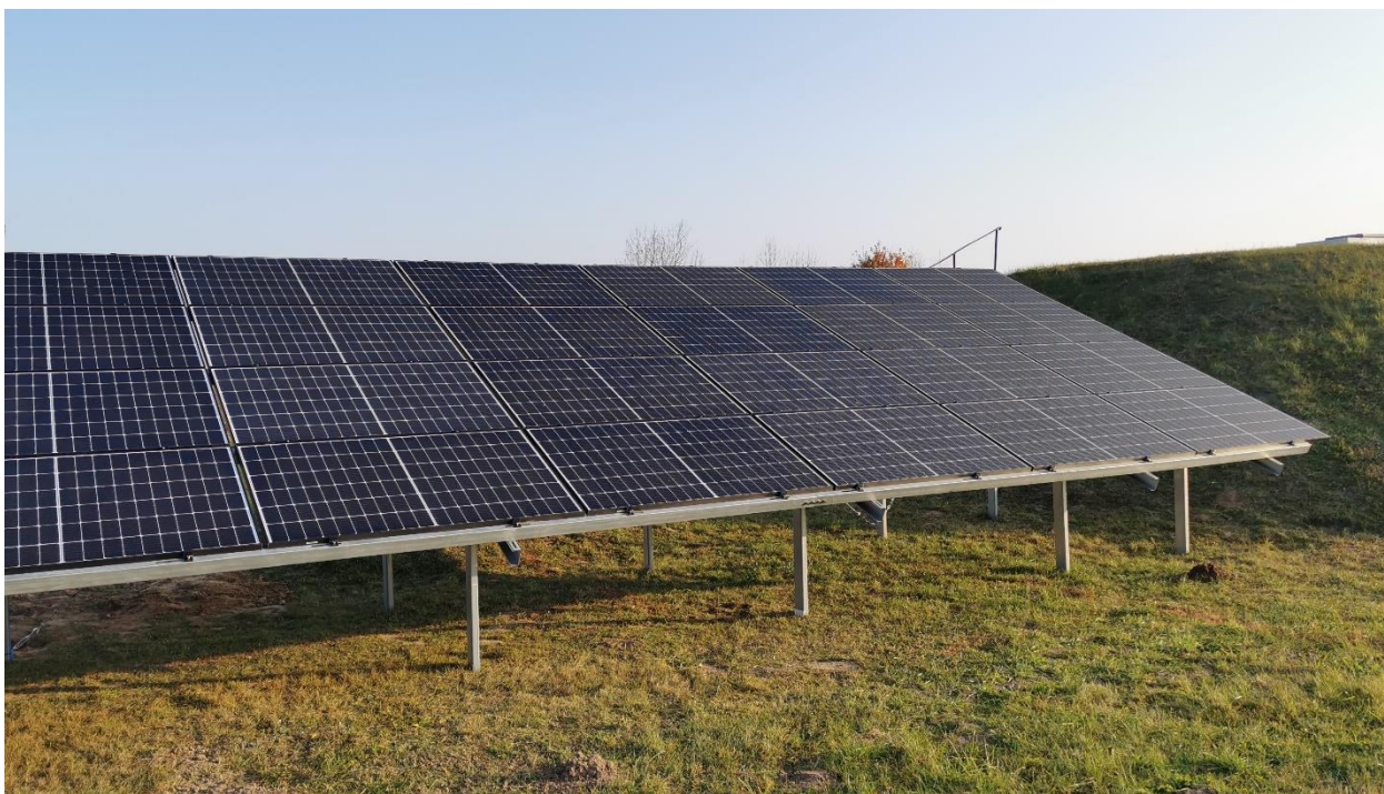
Zdjęcie 3 Dostawa i montaż instalacji fotowoltaicznej o mocy 19,5 kW przy hydroforni w m. Granice
