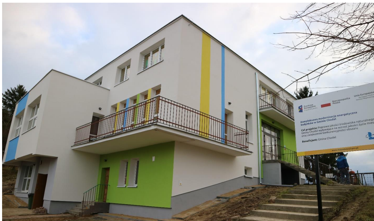
Zdjęcie 10 Kompleksowa modernizacja energetyczna budynku przedszkola w Ratoszynie Drugim
